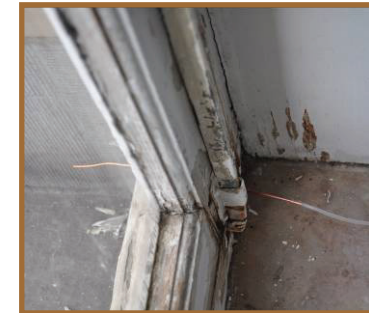
Mesure de la pression extérieure
